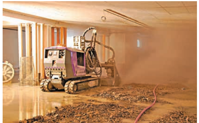
Bild 2: Beispiel Betonabtrag Bodenfläche
