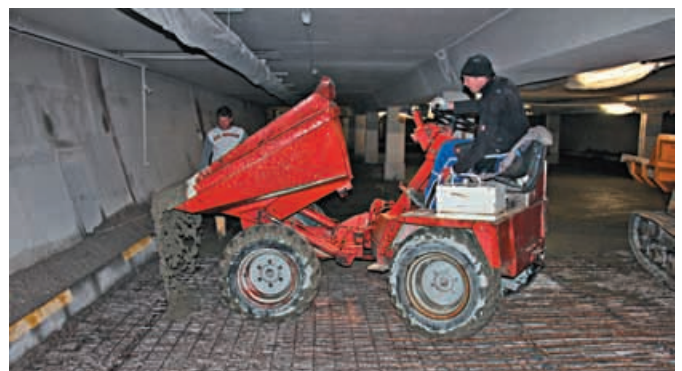
Bild 3: Betoniervorgang mittels Dumper
