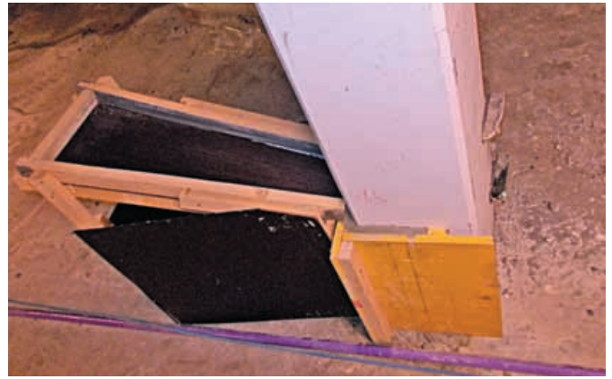
Bild 1: Instandsetzung Stützensockel in jeweils 4 Abschnitten
