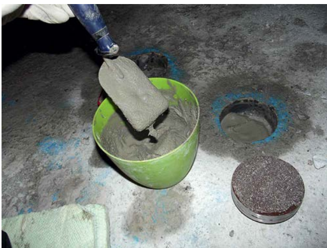
Abb. 5: Einbaubeispiel Sensor in einer Kernlochbohrung
